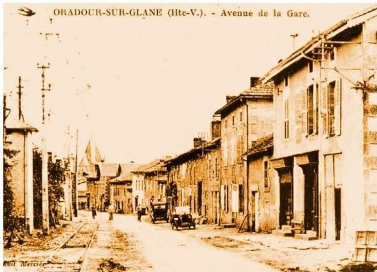
Avenue de la Gare – Oradour-sur-Glane
